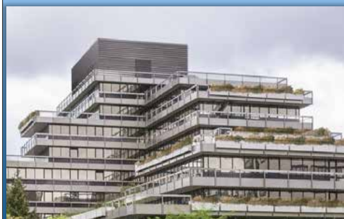
Transformatie Estel, Nijmegen
