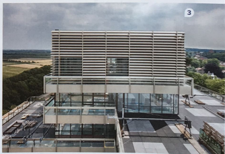
1 // Bij de gevelrenovatie zijn in de kopgevels glazen puien geplaatst met naar buiten draaiende deuren in het stramien van 1,25 meter. 2 // Detail van de bestaande stalen gevelkolommen waarop de nieuwe puien zijn gemonteerd. 3 // Het nog af te bouwen penthouse op de bovenste bouwlaag en de voormalige installatieruimte met lamellen-gevel. (Foto: Norbert van Onna)
