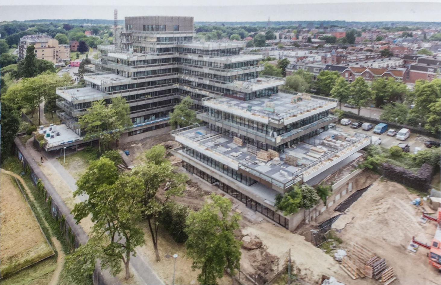
Alle woningen krijgen een dakterras en/of een (glazenwas)balkon met een afwerking van grote keramische tegels en een aangepaste borstwering. (Foto: Norbert van Onna)
